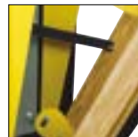
Sangles renforçant le maintien de la façade
